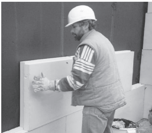
Bild 4: Verlegung der Dämmplatten im Verband
