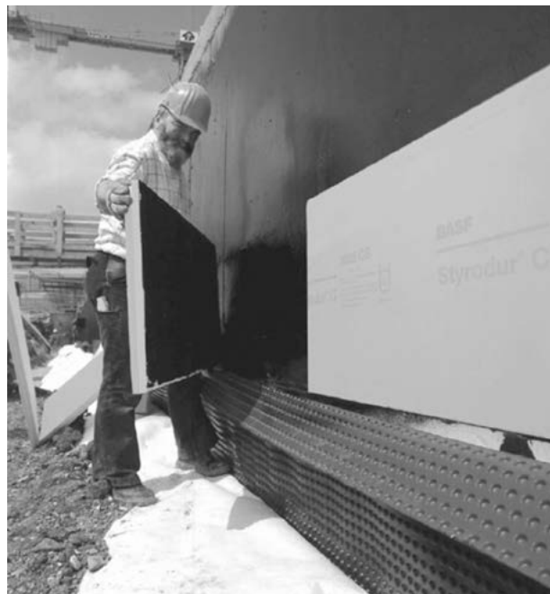
Bild 11: Vollflächige Verklebung der Dämmplatten
