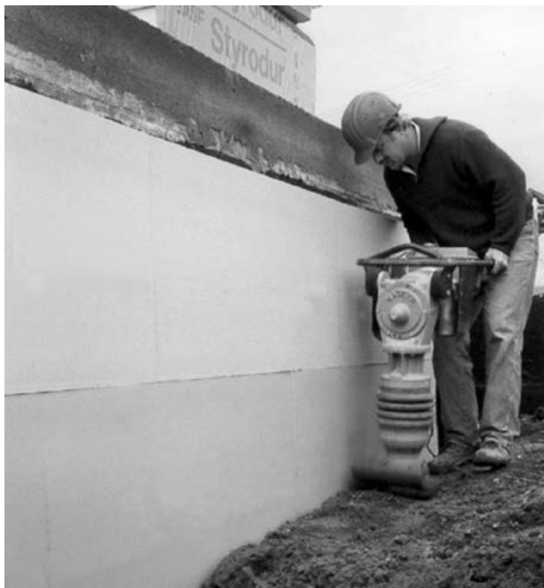
Bild 9: Lagenweise Verdichtung
