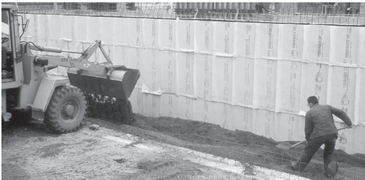
Bild 7: Einbau von Perimeterdämmplatten aus XPS mit integrierten Dränrillen und außenseitigem Filtervlies
