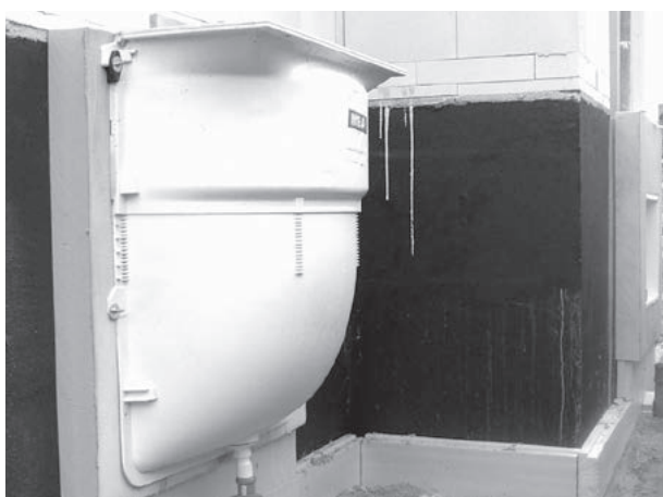
Bild 5: Wärmebrückenfreie Installation der Lichtschächte
