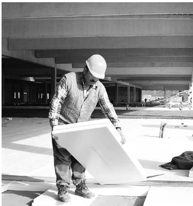
Bild 10: Verlegung der Perimeterdämmung unter der Bodenplatte
