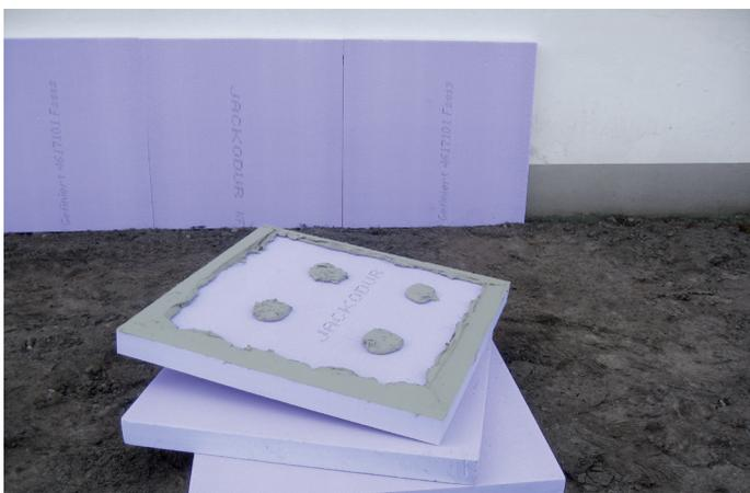
Bild 2: Sockeldämmung mit JACKODUR® Gefiniert im Wulst-Punkt-Verfahren
