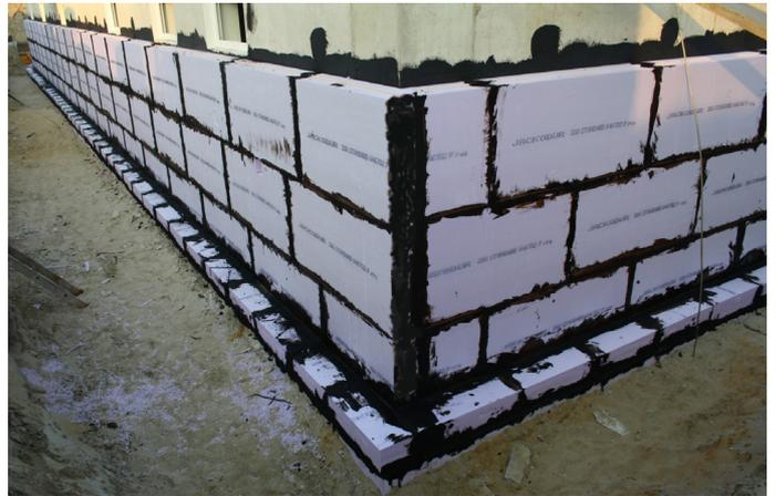
Bild: Verarbeitung der Perimeterdämmung im drückenden Wasser (Grundwasser)
