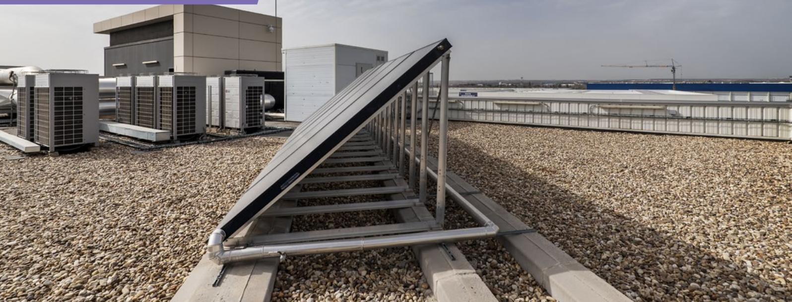
Bei einem bekiesten Umkehrdach wird auf dem wasserableitenden JACKODUR® Dachvlies WA eine Schicht aus Kies aufgebracht, die gleichzeitig mehrere Funktionen hat:
