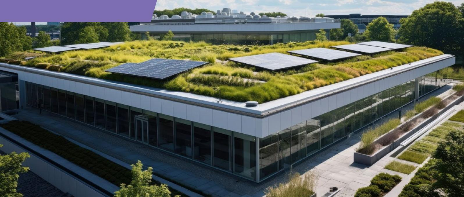
Ein **Retentionsdach** bewirkt bei starken Niederschlägen, daß Regenwasser direkt auf den Dachflächen zurückgehalten wird und gedrosselt abläuft. Der zeitverzögerte Ablauf entlastet die Kanalisation und Vorfluter. Retentionsdächer lassen sich als bekieste oder begrünte Umkehrdächer ausführen.
