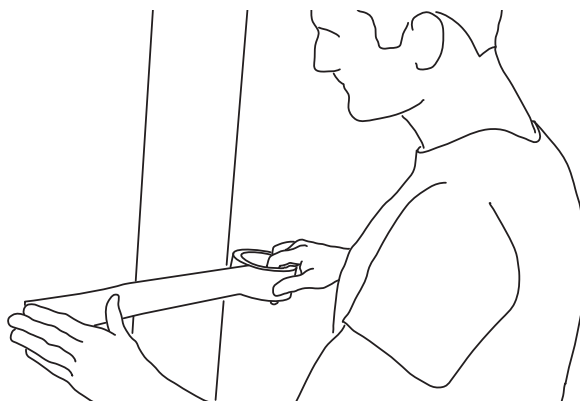
6) Zum besseren Halt empfiehlt es sich die Wandelemente auf der Rückseite mit einem Klebeband zu fixieren.
