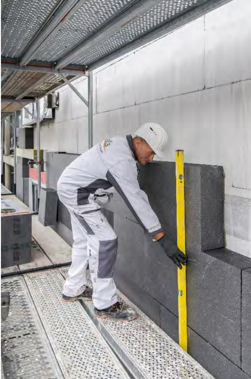
Abbildung 2. Nahaufnahme einer EPS-Dämmplatte (Quelle: IVH, EUMEPS, NEPSA und EPS-Branchen).
