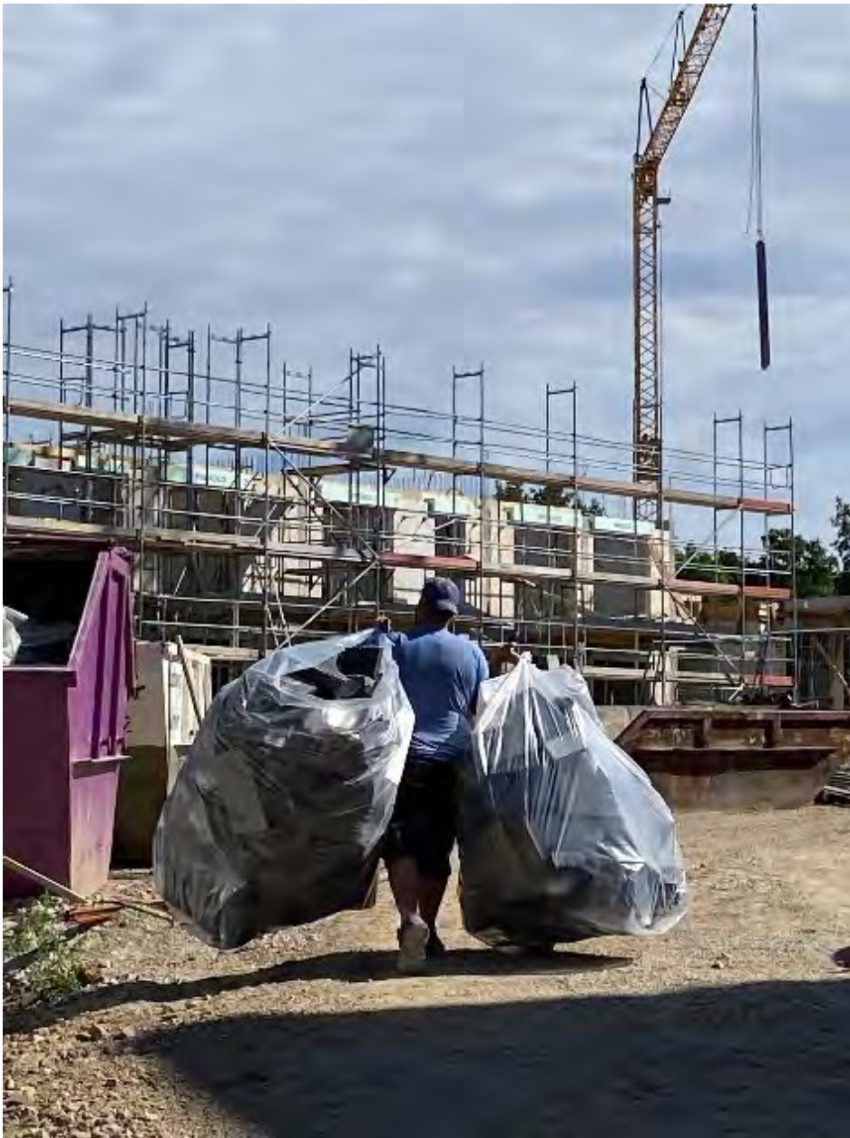
Abbildung 3. Sammlung von EPS-Verschnittresten auf einer Baustelle (Quelle: IVH, EUMEPS, NEPSA und EPS-Branchen).
