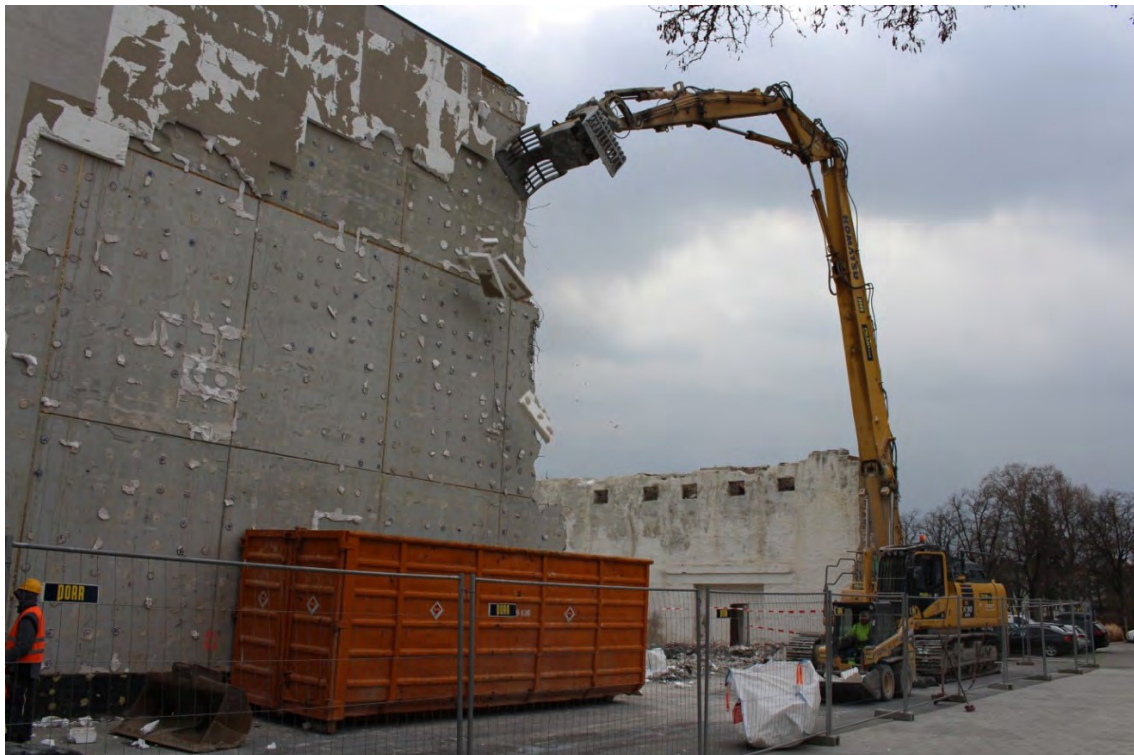
Abbildung 6. Beispiel für die Sortierung von EPS/XPS-Abbruchabfällen (Quelle: IVH, EUMEPS, NEPSA und EPS-branchen).
