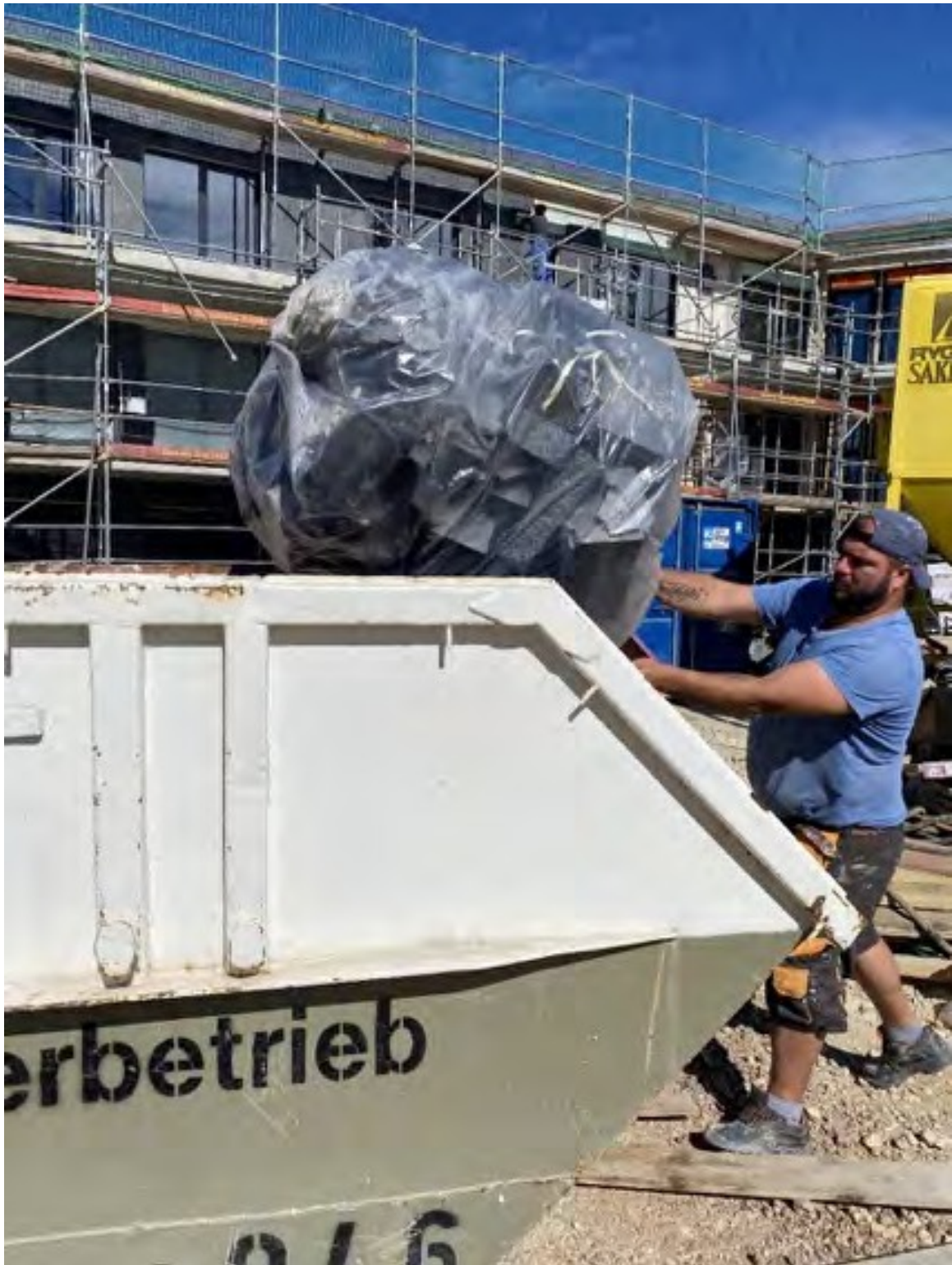
Abbildung 1. EPS/XPS auf einer typischen Baustelle (Quelle: IVH, EUMEPS, NEPSA und EPS-Branchen).
