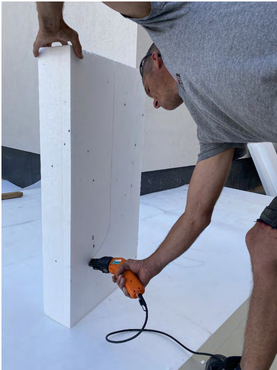
Abbildung 4: Arbeiter beim Schneiden von EPS mit einem heißen Draht (Quelle: IVH, EUMEPS, NEPSA und EPS-branchen).
