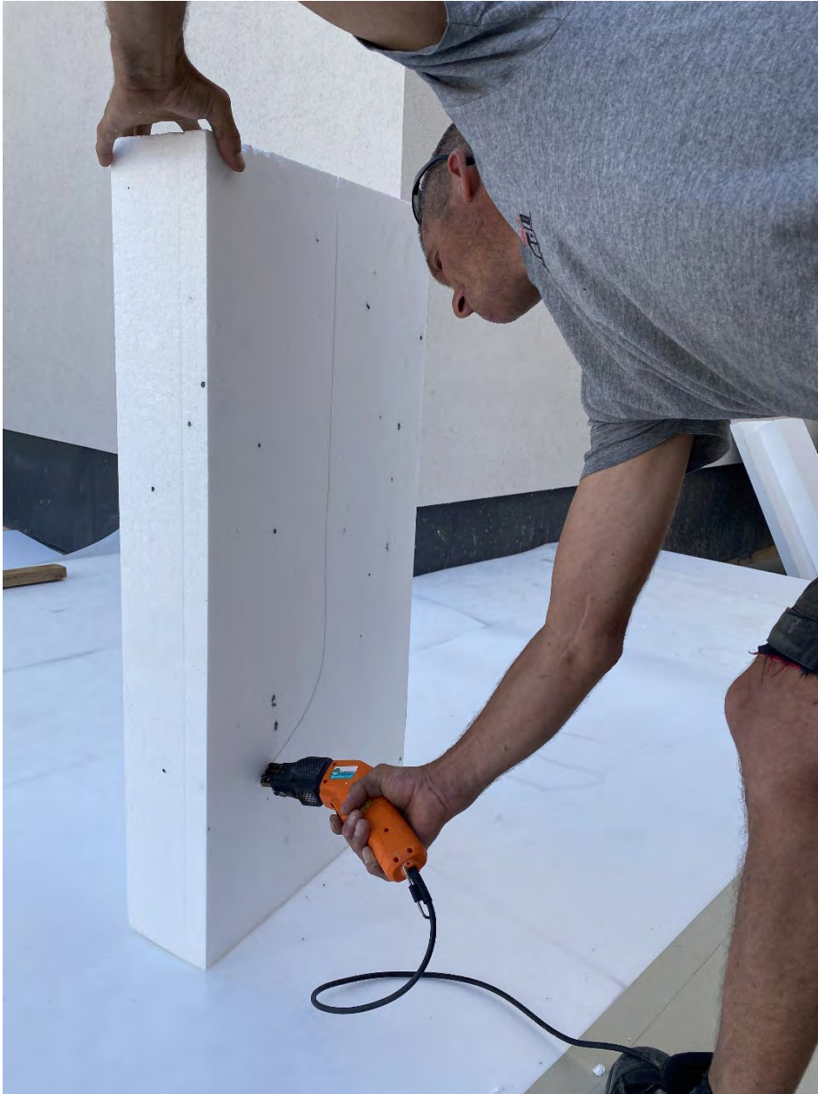
Abbildung 2A. Verwendung von Schneidwerkzeugen (Quelle: IVH, EUMEPS, NEPSA und EPS-branchen).
